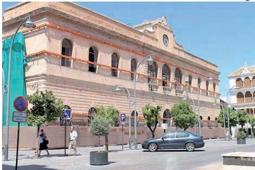
obras ayuntamiento de Écija
