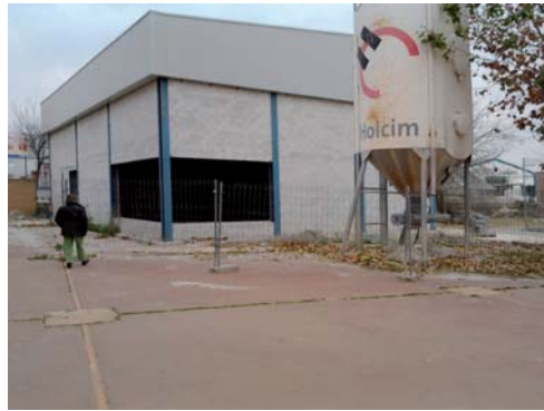
obras polideportivo municipal
